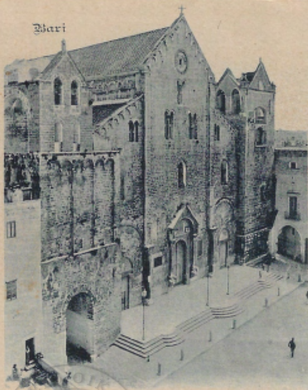
Facciata della Chiesa S. Nicola
